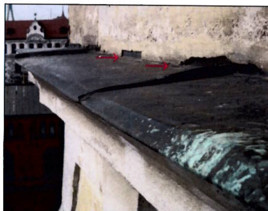
24. att. → Dzegu noseiglošņu salaidumi ar zeltiņa fasādi ir ar izdrupumiem
