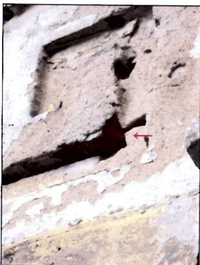
← 15. att. Atsegtās māla ķieģeļa šķautnes sairšana tuvplānā (vietu sk. 10. att.)
