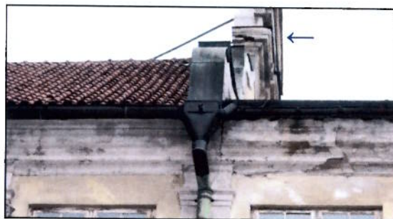
14. att. → Ķieģeļu korozija (lokāls posms) dzegas galā Doma dārza pusē
