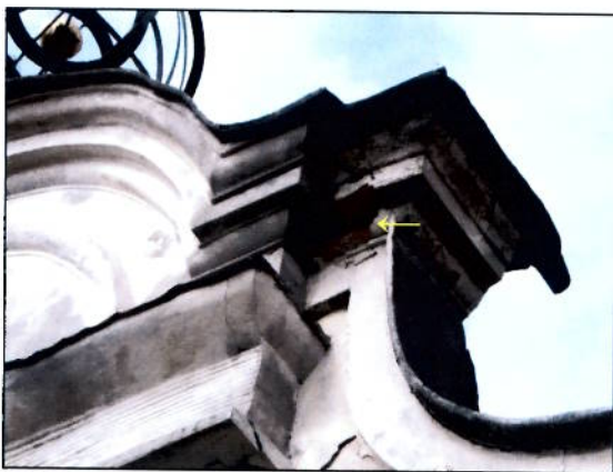
14. att. → Ķieģeļu korozija (lokāls posms) dzegas galā Doma dārza pusē
