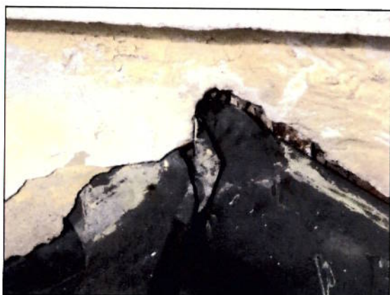
23. att. Neimaņa piebūves pusē jumta seguma ielaidums paviršs — mūrējumā var iekļūt nokrišņu ūdens
