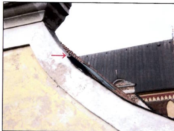
22. att. Atrauts zeltiņa virsu nosedzošs skārda loksnes posms (Jaunielas pusē)
