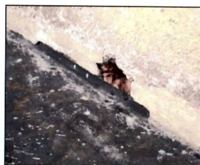
16. att. Bojāts ķieģelis pie dzegas nosegloksnes malas (ielaiduma vietā, zelmiņa vidusdaļā)
