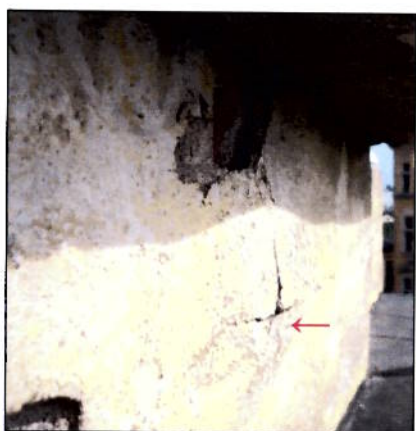
← 17. att. Lokāli izspiedies un saplaisājis apmetums (zem dzegas zelmiņa apakšā dienvidu pusē)
