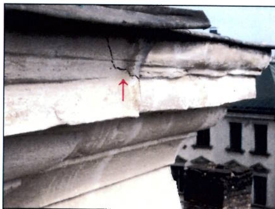
← 21. att. Iepriekš ir tikusi labota fasādes apdare, t.sk. aiztērējot plaisājumus
