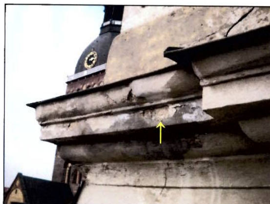
18. att. → Izdrupusi apmetuma virsma (dienvidu fasāde, rietumu mala)
